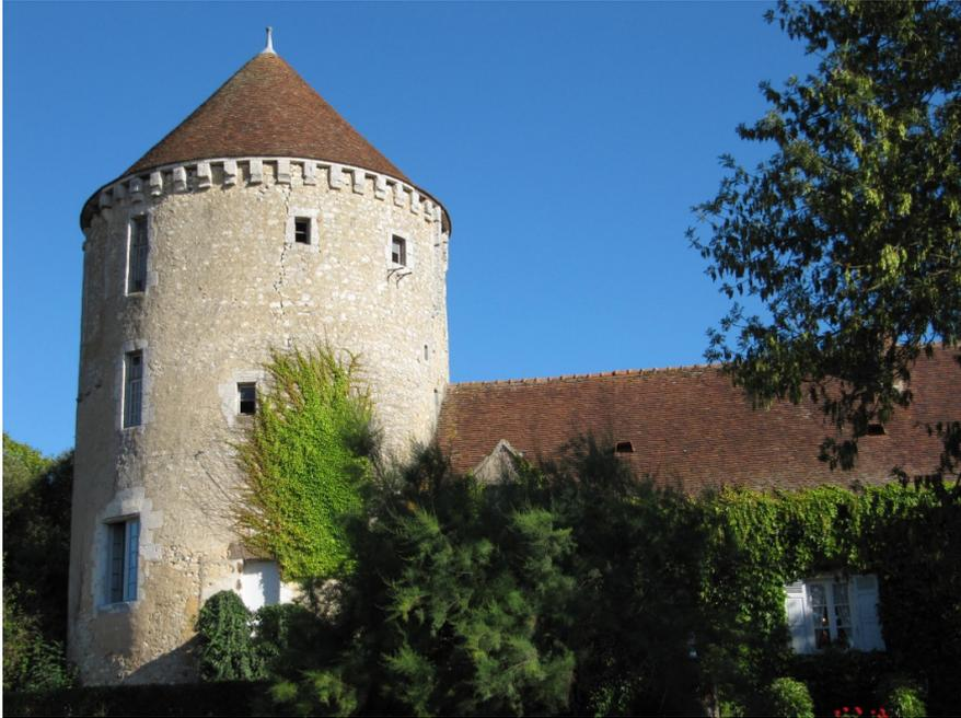
L'actuelle tour de Beaugard est construite vers 1450-1500, le corps principal comporte une tour à 3 étages. L'escalier existant est construit dans l'épaisseur des murs. La tour est couverte d'un toit conique reposant sur une rangée de gros corbeaux de pierre, elle était garnie de hautes bretèches descendant jusqu'à mi-hauteur (logettes rectangulaires en surplomb dont le sol, percé de trous, permettait le tir fichant, c'est-à-dire frappant presque verticalement l'objet.).
