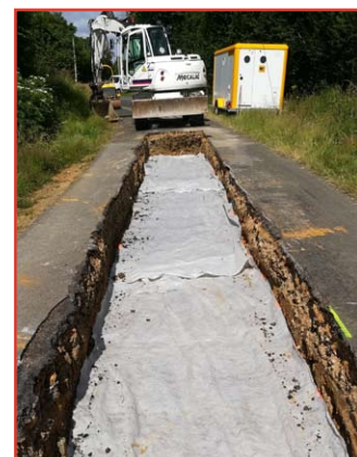
Haut et bas : la route du Meslier, avant, pendant et à l'issue des travaux de réfection.
