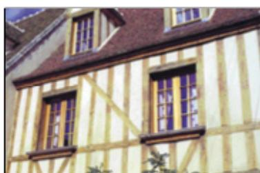
La garniture de briques est plus fréquemment utilisée pour les maisons de ville, bien que dans le sud-est du Perche-Gouet, ainsi que dans la région de La Ferté-Vidame, on remarque quelques constructions rurales qui en comportent. Le *hourdis\** en maçonnerie enduite (mortier de chaux) est fréquent dans les bourgs. Enfin, le pan de bois des murs périmétriques repose sur un *bahut\** en maçonnerie de pierres et mortier de chaux.
