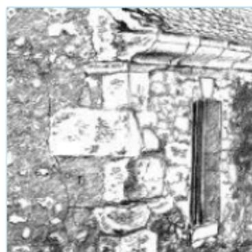
Raccordement d'une corniche en pierre sur une chaîne d'angle
