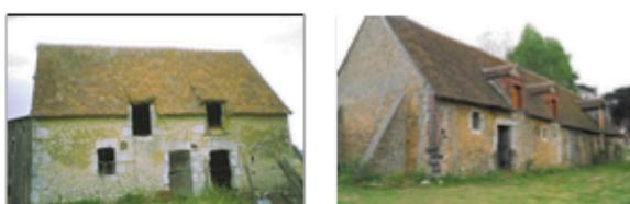
La fenêtre correspond toujours à l'exacte mesure de l'espace à éclairer et ventiler, en tenant compte des usages et moyens des familles (techniquement et économiquement). Elle est positionnée dans un rapport d'espacement qui laisse largement dominer le mur plein. Les seuls rapprochements (ou associations) admis se font avec la porte d'entrée.
