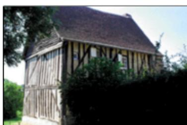
Une pièce horizontale (formant *panne\** intermédiaire pour l'assemblage des poteaux et doublant la *sablère\** de toiture) permet d'augmenter la hauteur de la construction tout en conservant une longueur standard aux *poteaux de rem-plissage\**. Cette forme correspond généralement à la position du plancher du grenier. La charpente du triangle de pignon ne comporte qu'exceptionnellement des pièces de contreventement, la hauteur en est recoupée par un petit *entrait\**.
