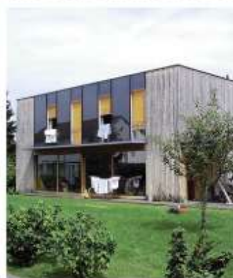
Les capteurs posés verticalement participent pleinement de la composition de la façade. Maison individuelle à Wolfurt (Vorarlberg, Autriche) © CAUE 78
